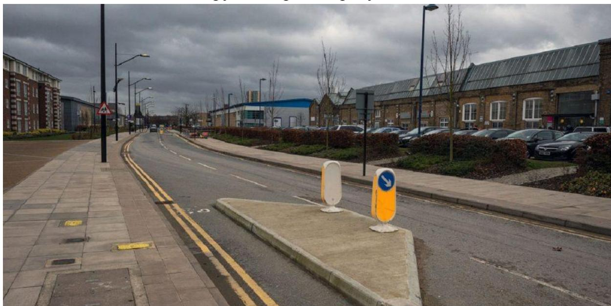
Рисунок 2.4.5 – Пример канализированного движения
